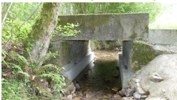
Pont vu de l'amont
