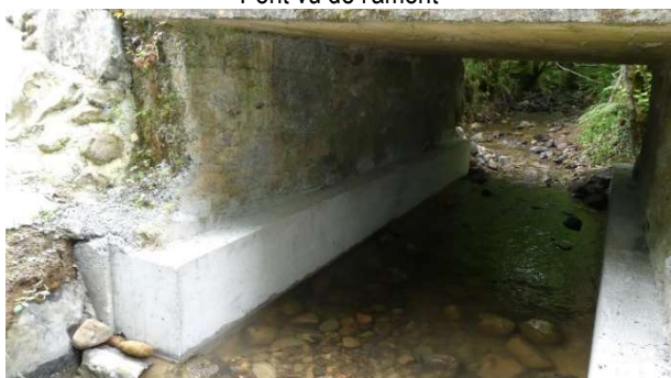
Vue renfort culée rive droite
