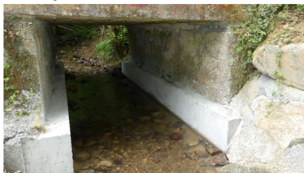
Pont vue de l'aval
