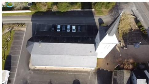
Les descentes au niveau des toits inférieurs ont été supprimées car non adaptées en cas de fortes précipitations. L'eau désormais se diffuse sur tout le toit pour atteindre la gouttière du bas.
