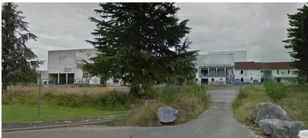
Le bâtiment principal de l'usine Vilcontal
