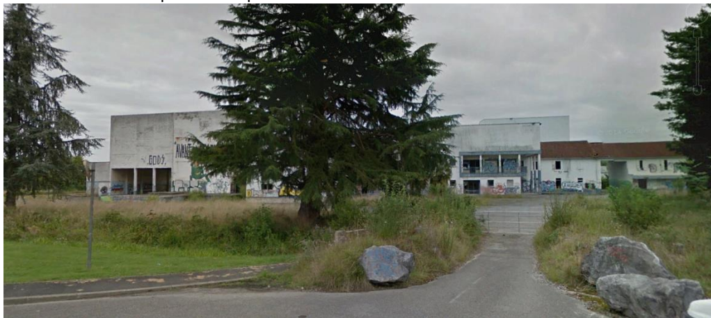
La friche industrielle Vilcontal, avant sa démolition, classée en zone AUa
