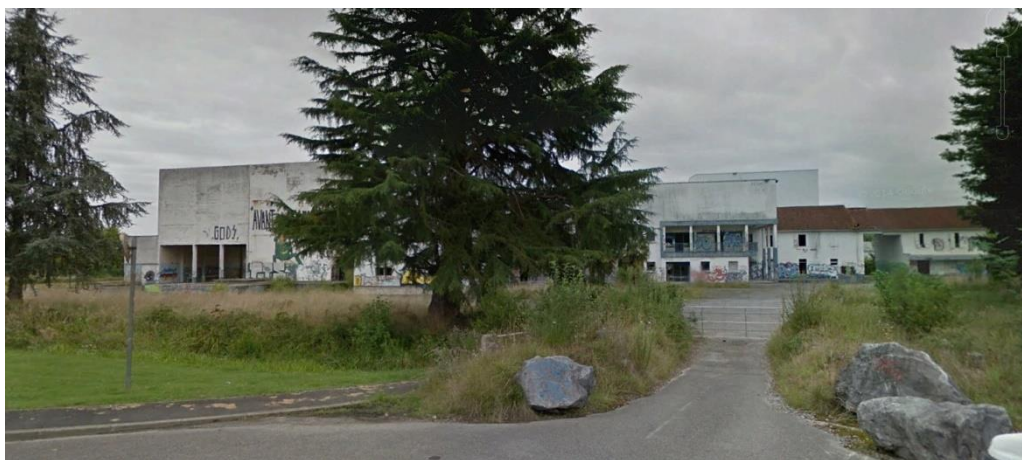
Le bâtiment principal de l'usine Vilcontal
