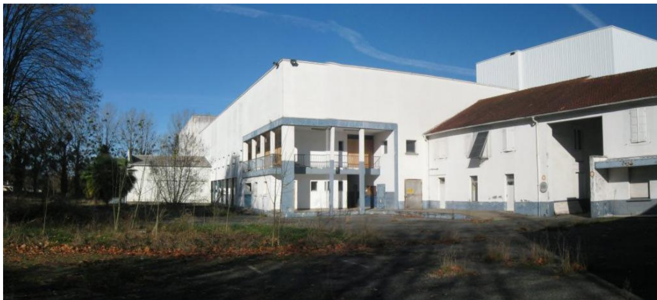
Le bâtiment principal de l'usine Vilcontal
