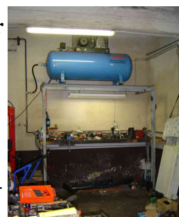
Surélévation d'un compresseur. [CETE Méditerranée]
