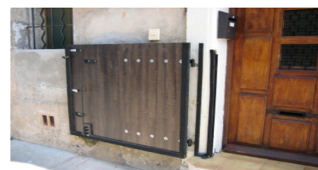
Exemple de batardeau (dispositif permanent) [CETE Méditerranée]
